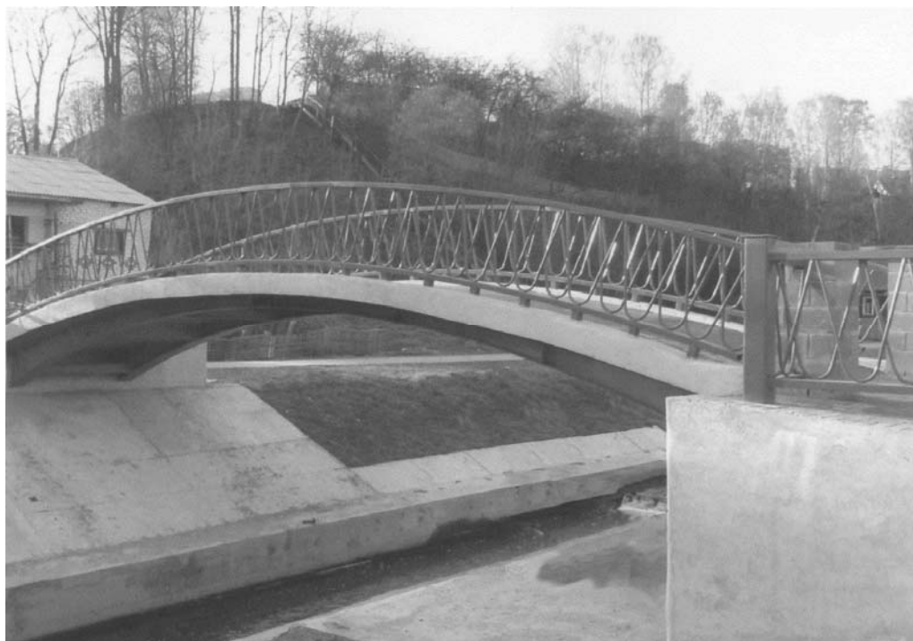
Рисунок 2 - Мост через р.Дубровенка в г.Могилеве
