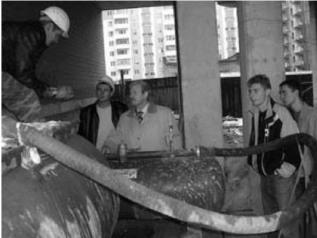
Рисунок 1 - Общий вид мобильной установки для приготовления ячеистобетонной смеси на строительной площадке для устройства ограждающих конструкций с повышенной теплозащитой при возведении каркасного жилого дома из монолитного железобетона
