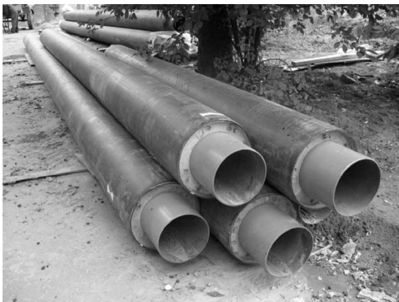
Рисунок 2 – Трубы, изолированные пенополиуретаном (ППУ), применяемые при прокладке теплотрассы по ул. Луначарского в Брянске
